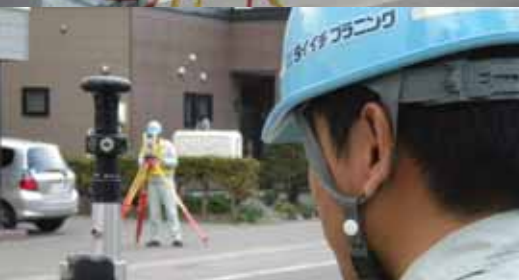
街中の現況測量の様子
