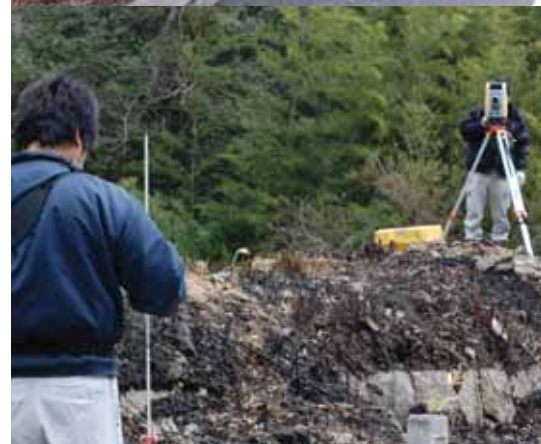
電子平板とTrimble S6を 組み合わせた現況測量
